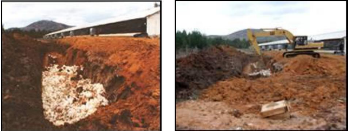
Figure 10. Fosas de enterramiento para una gran cantidad de aves
