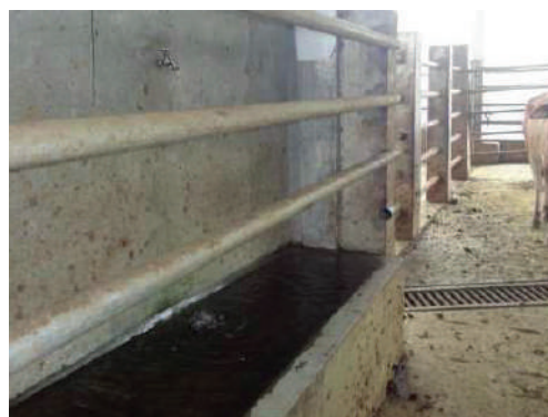
Imagen 14.- Rejillas de desagüe en corrales de alojamiento mal ubicadas.
