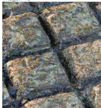
Imagen 18.- Ejemplo de piso antideslizante.
