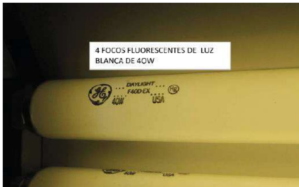
Fotografía 3, Características de la luminosidad requerida en la mesa de inspección.
