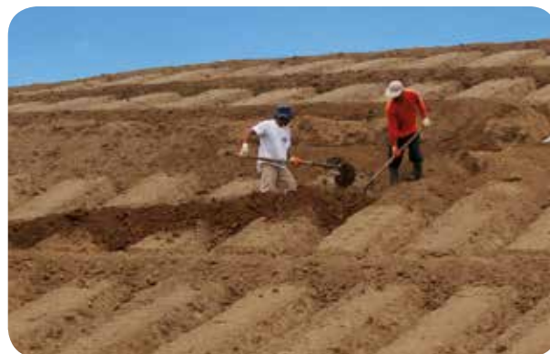
Elaboración de zanjas para drenaje de agua.
