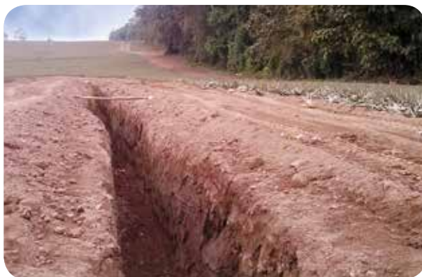
Zanjas primarias en áreas sin pendientes.
