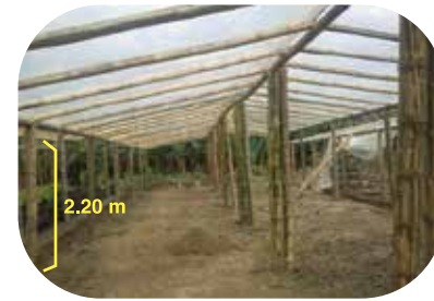
Material para ramada: caña guadúa, madera. Alturas laterales 2.20m Hda. Secadal (foto Intercalidad)
