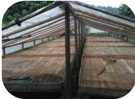
Marquesina (foto Ing. Wilson Montoya)
