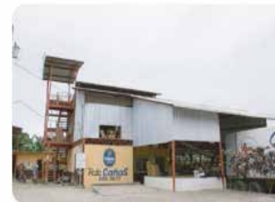
Fosa de estacionamiento de contenedores y camiones de transporte.
