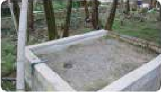
Cajón de grava para sedimentación de fluidos de agua para fumigación.
