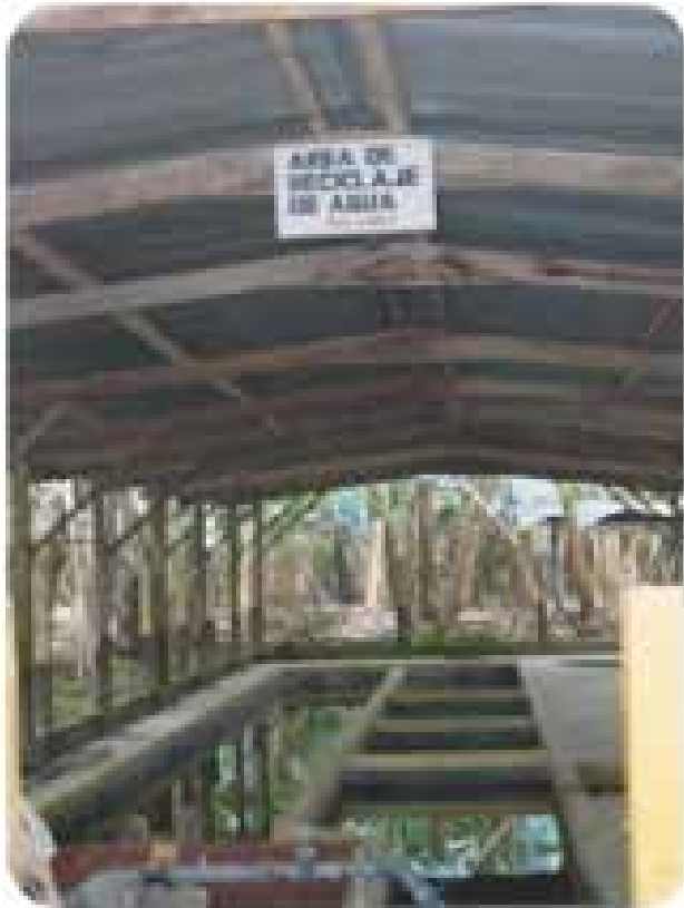
Tratamiento para reciclaje del agua.
