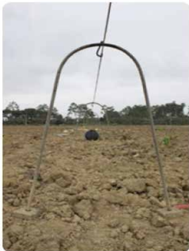
Instalación de cable vía.
