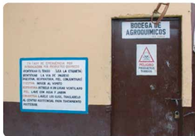
Bodega de Agroquímicos.
