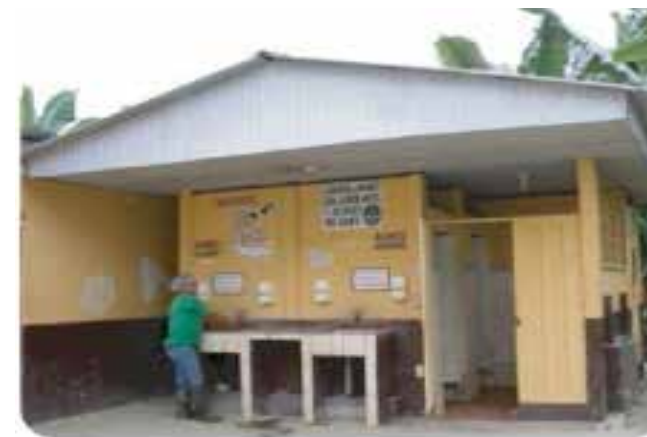
Baterías sanitarias para el personal.
