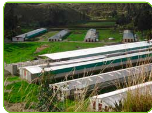
Construcción de galpón con techo a dos aguas
