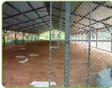
Galpón previo a la limpieza
