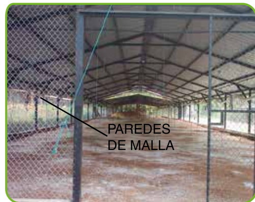
Malla en los ventanales
