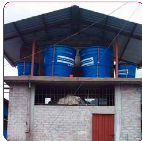
Tanques de agua con cubierta
