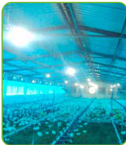
Iluminación eficaz con focos fluorescentes
