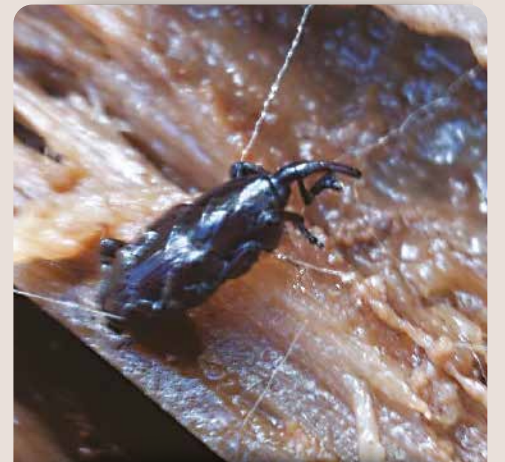
Daño por insectos
