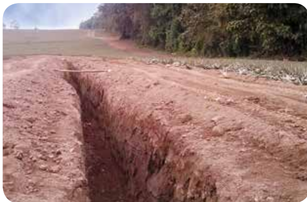
Zanjas primarias en áreas sin pendientes.
