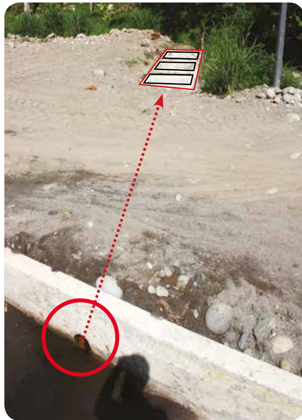
Zona de lavado de tanques de plaguicidas y / o combustibles, indicando canal de recolección y fosa de tratamiento de residuos tóxicos.
