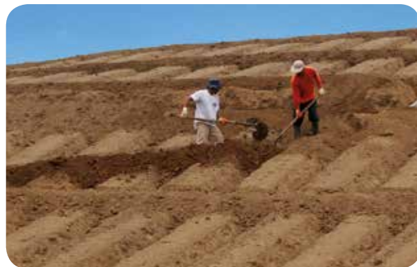
Elaboración de zanjas para drenaje de agua.
