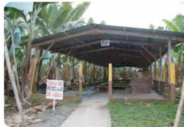
Sistema de tratamiento de agua de la empacadora, con reciclaje.
