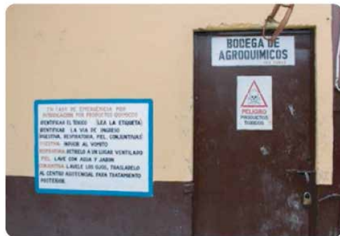
Bodega de Agroquímicos.
