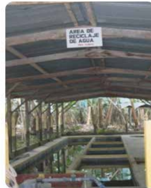
Area de reciclaje de agua.
