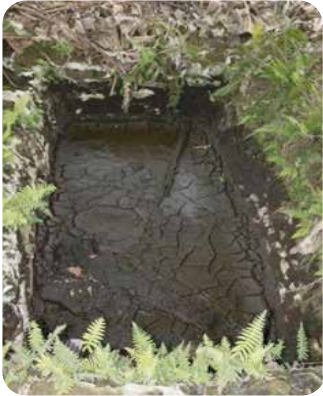
Fosa de sedimentación de residuos sólidos.
