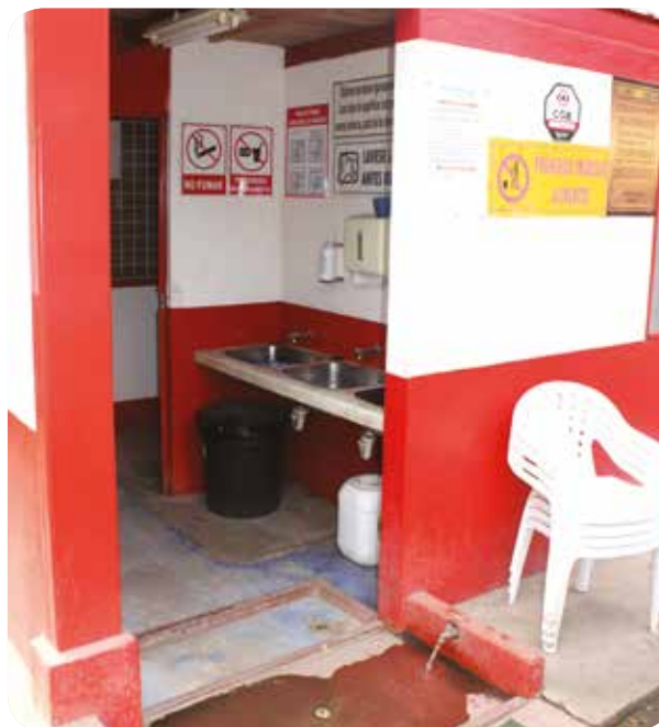
Instalaciones de lavado de manos al ingreso de la planta, completamente equipadas con agua, jabón líquido, desinfectante e indicando el proceso de lavado y desinfección de manos.
