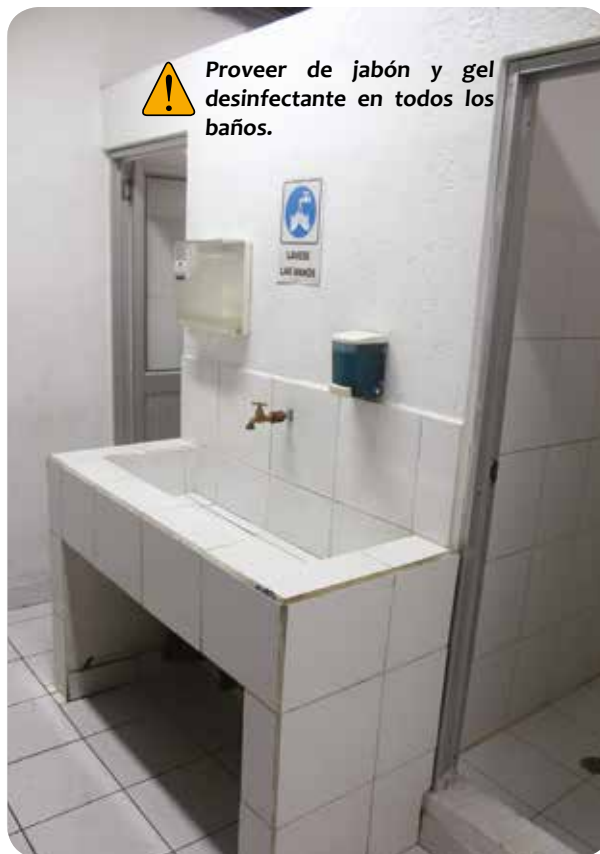
Limpieza en baños.
