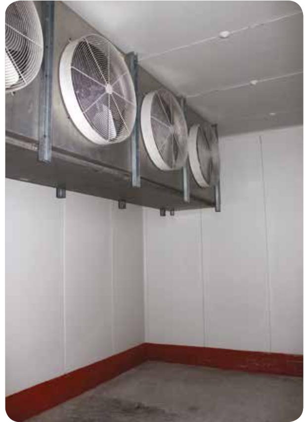
Cuartos fríos sin condensación.
