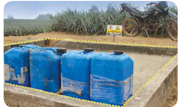
Cubeto de mezcla y contención de derrames de agroquímicos en campo.
